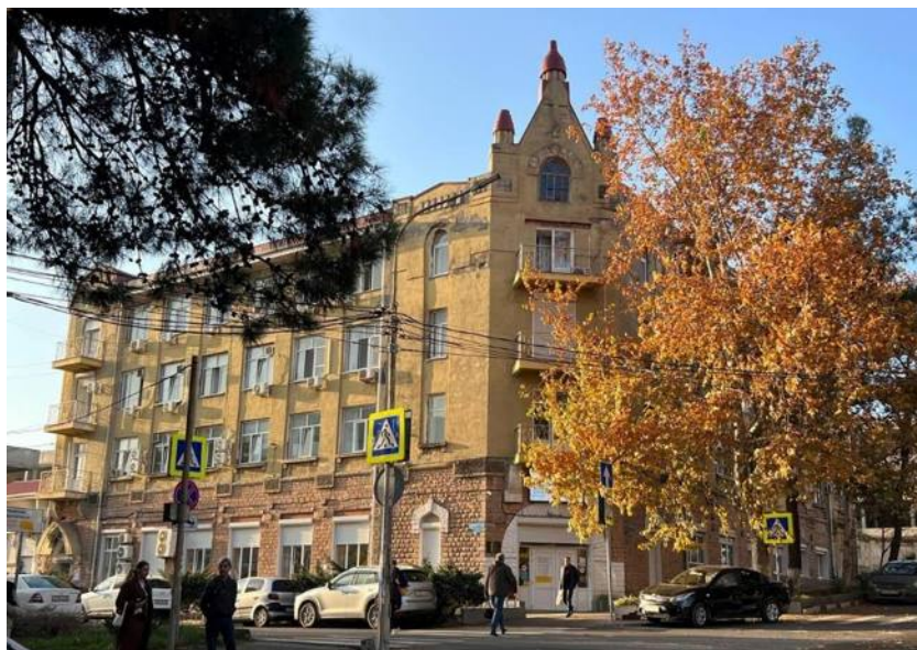
Рис. 1. Четырёхэтажный дом, построенный в 1903 г. кубанскими купцами Богарсуковыми, где размещалась Новороссийская экспедиция заготовления государственных бумаг (современное состояние; фото «Новороссийский рабочий»).
