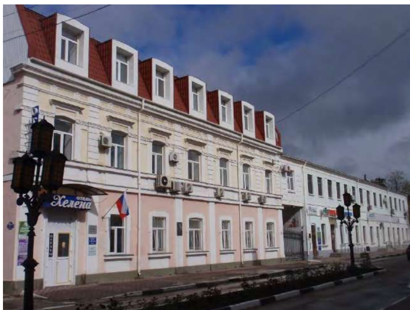
Рис. 2. Сохранившиеся здания Феодосийской ЭЗГБ на улице Земской в Феодосии (фото автора).
